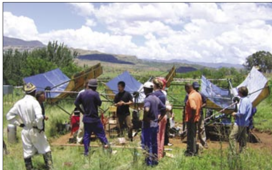
PHOTO COURTESY / MIT SOLAR TURBINE GROUP
